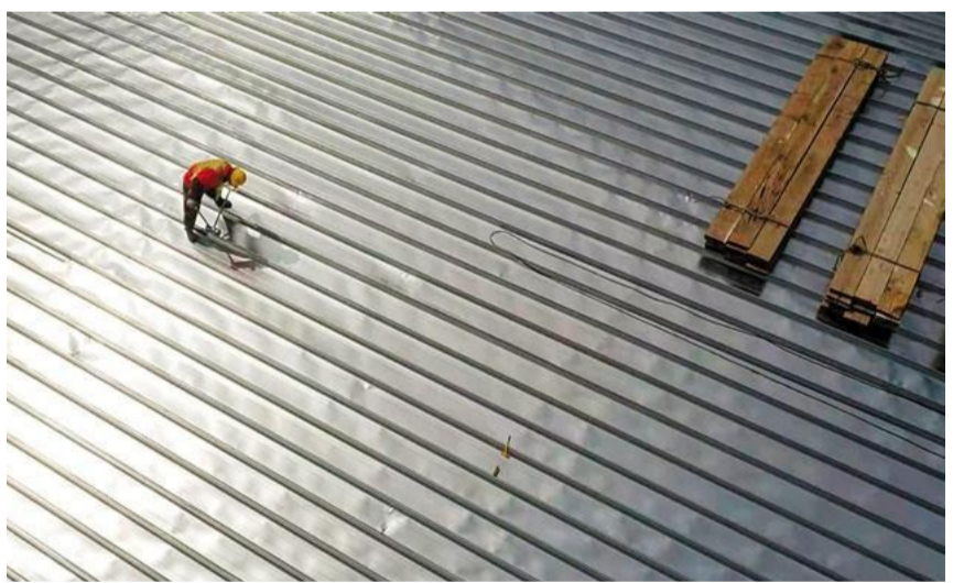
施工人員在亞青會主場館安裝金屬屋頂。
